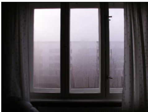
Abbildung 16: Erhebliche Tauwasserbildung auf der Innenseite der Außenscheiben eines Kastenfensters (Bildquelle: Dirk Sommer, Berlin)
