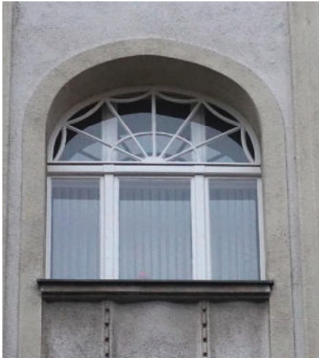
Nur in Holzkastenfenstern können filigrane Sprossen ausgeführt werden.
