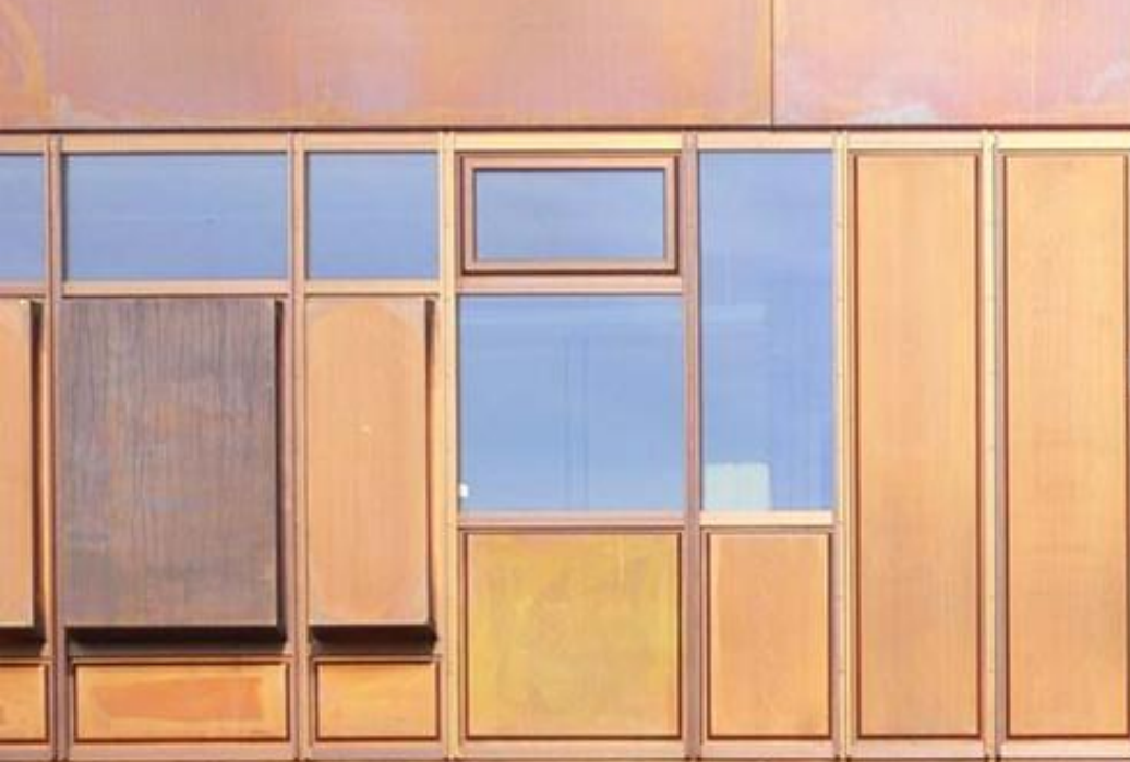
“Rostlaube” nach Sanierung.
